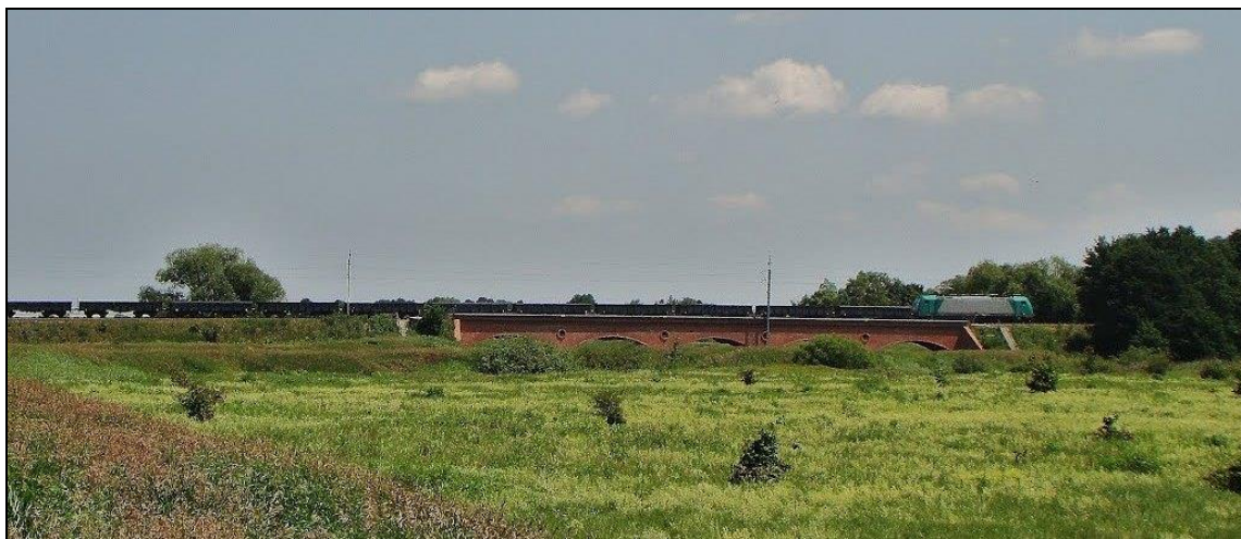
Linia kolejowa w sąsiedztwie obszaru opracowania
