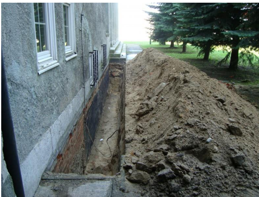
Rysunek 3 Docieplenie budynku szkoły w Miliczu, [źródło: http://lo1milicz.pl/cms/index.php/remonty/1405-docieplenie-budynku-szkoly ]
