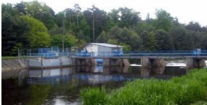
Rysunek 8 Mała elektrownia wodna na Baryczy, [źródło: http://www.gridw.pl ]
